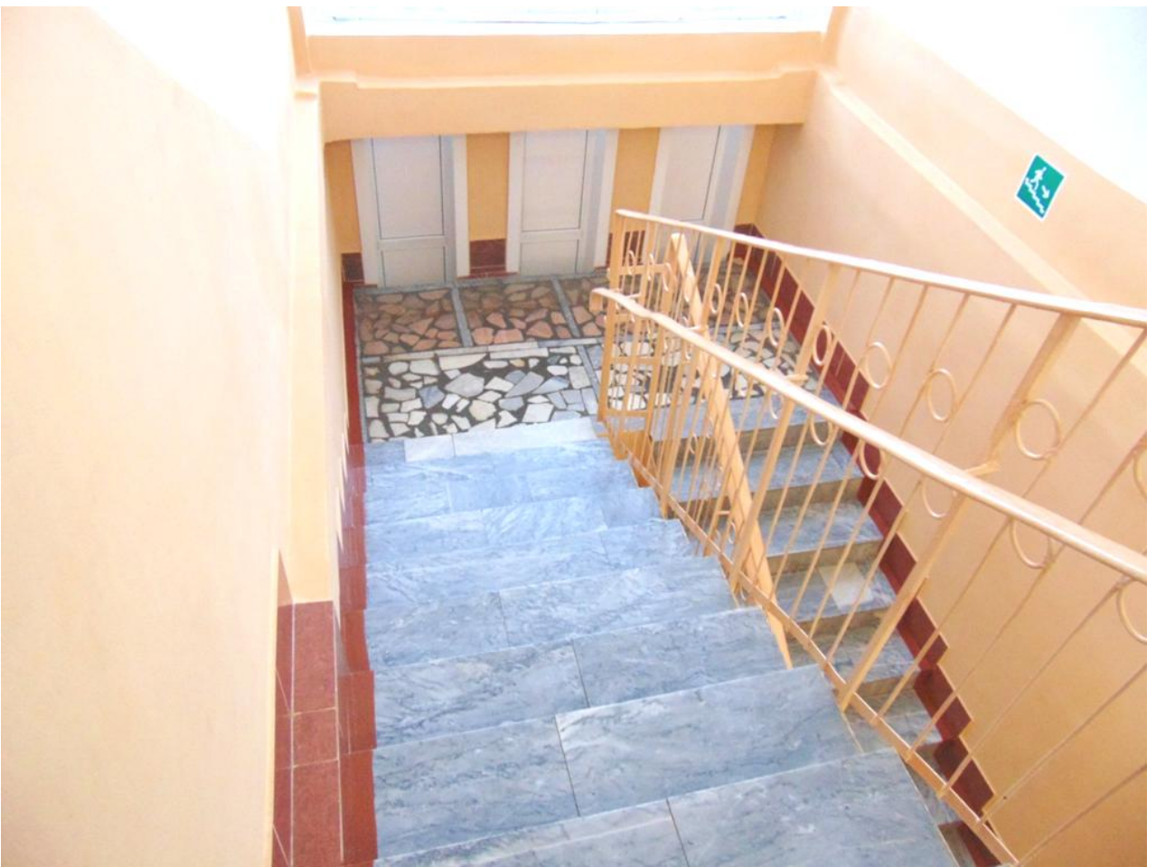
Фото№17. Лестница (внутри здания)
