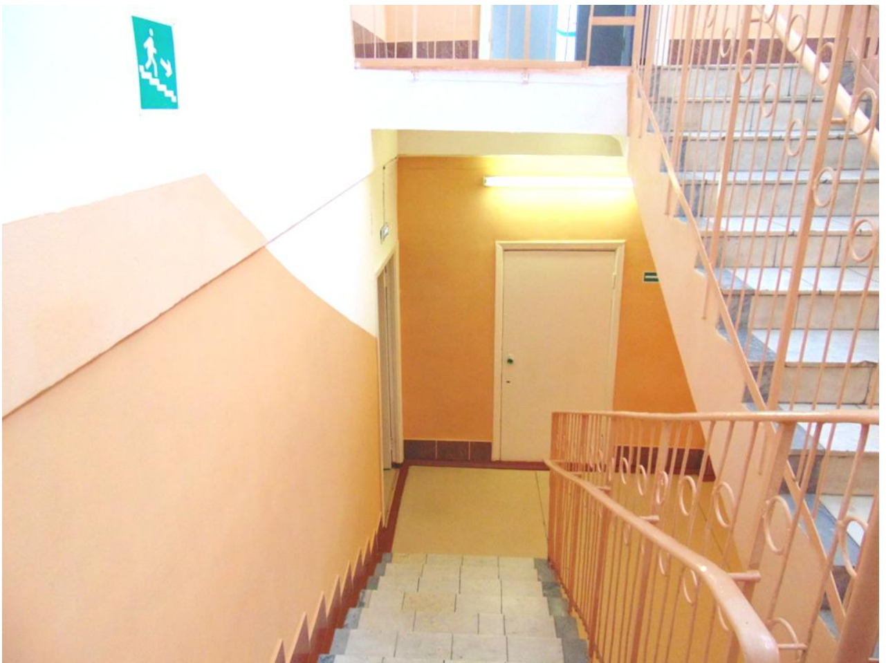
Фото№15. Лестница (внутри здания)
